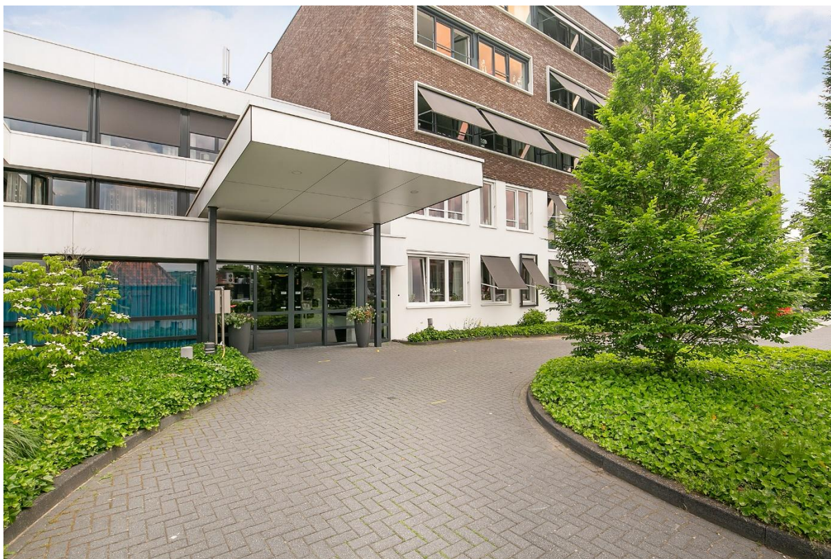
Centrale entree woonzorgcentrum de Molenkamp
